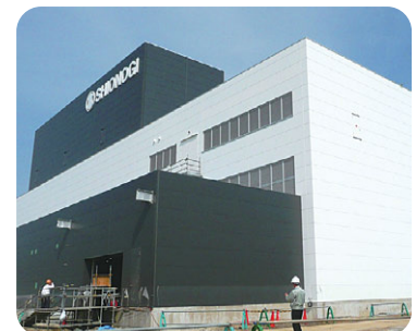
● 摂津工場「新固形製剤棟」 (2008年11月竣工予定)
