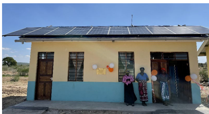
<ソーラーパネルが設置された産科棟>
