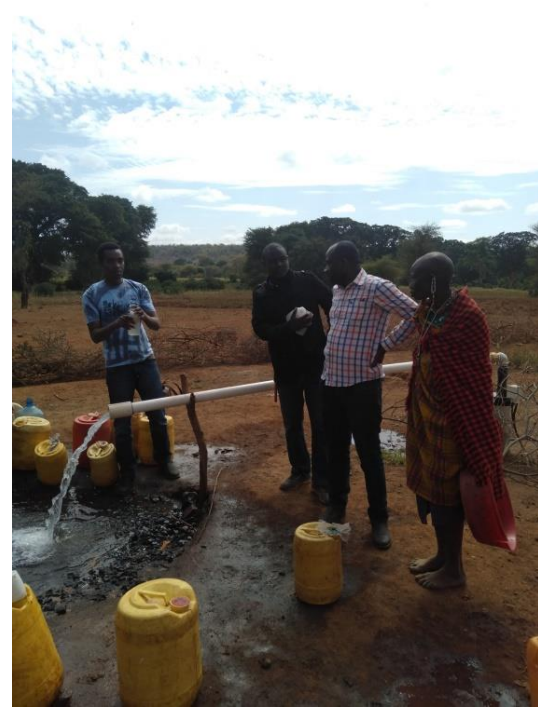
地下水汲み上げ井戸（borehole）
