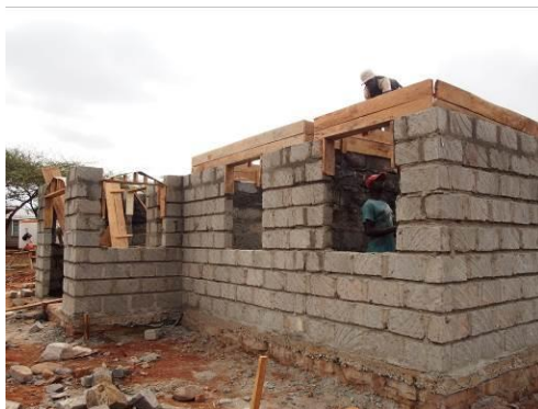
産科棟の建設
