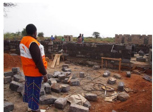
スタッフ宿舎の建設
