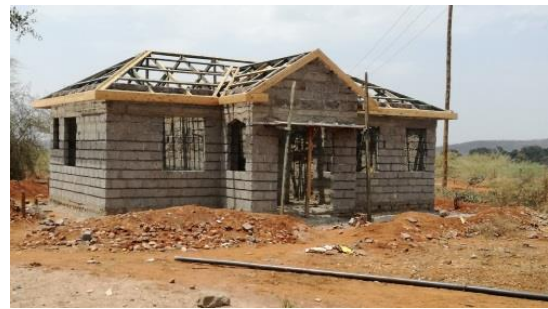
スタッフ宿舎の建設
