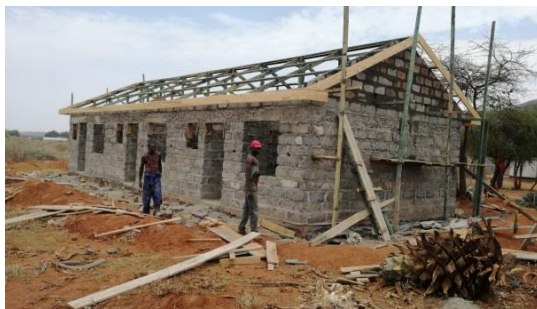
産科棟の建設
