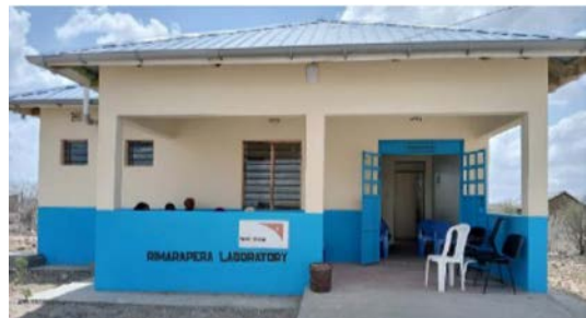
リマ・ラ・ペラ臨床検査室
