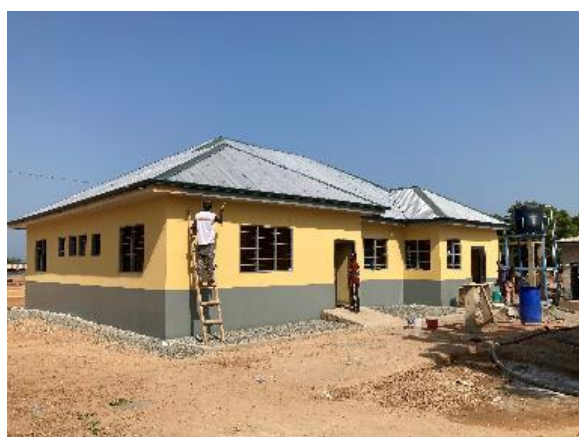
1-3 分娩棟の建設および基礎的保健医療資器材の供与(アカテン)(写真:完成したアカテン分娩棟。2025年11月撮影)
