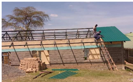
屋根の張り替え工事
