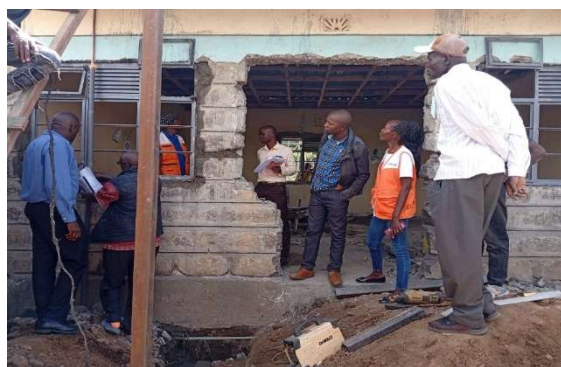
ギルギル準県のエンジニアとの 整備工事の共同モニタリング
