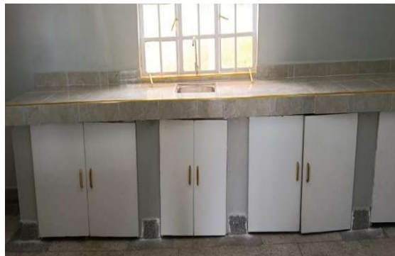
完成した検査台
