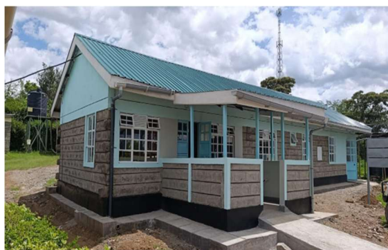
完成間近の母子保健棟と検査室
